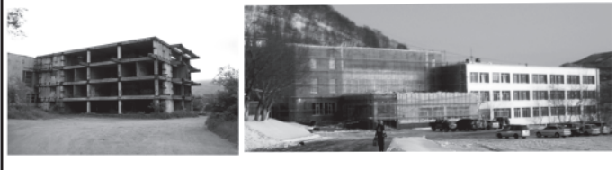
ул. Ленинградская здание Камчатскгражинскпроект
