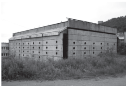
ул. Ленинградская здание бассейна КамчатГТУ
